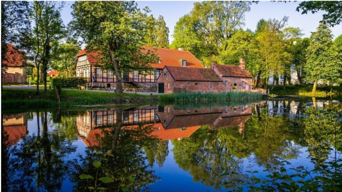
Einst Wirtschaftsbauten, heute Gästeunterkünfte. © Foto: Weissenhaus
